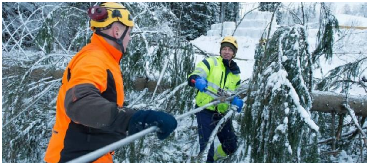
Figur 6 Linjearbeidere håndterer høyspenningsledning som er tatt av trefall
